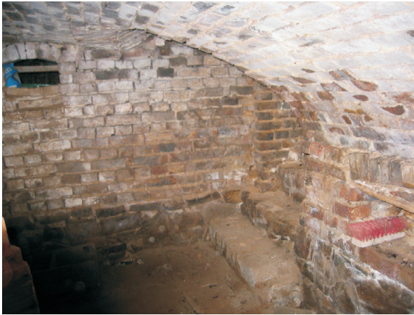
Kartoffelkeller, genutzt als Luftschutzraum
