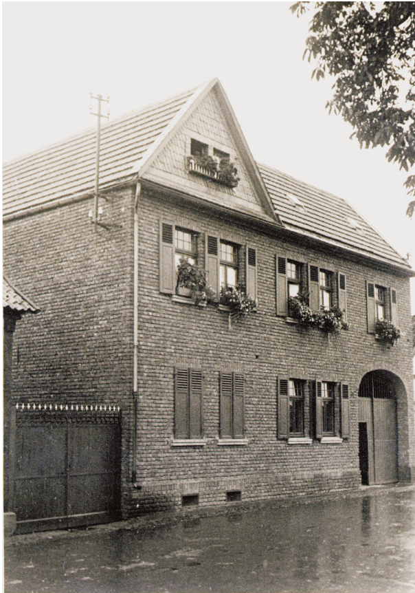
Das 1913 von Opa Hubert Wißkirchen gebaute Haus in der Ollheimer Str. 32. Hinter den geschlossenen Läden befand sich das ‚Gute Zimmer‘ mit Klavier, das nur an Festtagen betreten wurde.
